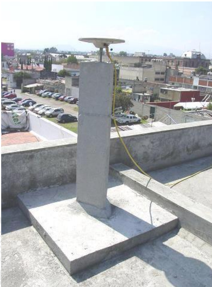
Figura 26. Coordenadas y detalle del Punto TOL2 que se utilizó para el amarre de coordenadas de la red de puntos de control del levantamiento LIDAR (Ligth Detection and Ranging), de la Licitación LA-909024988-N2-2014.
